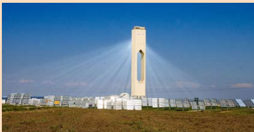
De eerste Europese commerciële zonnetoren (2007): de PS10 bij Sevilla van 11 MW
