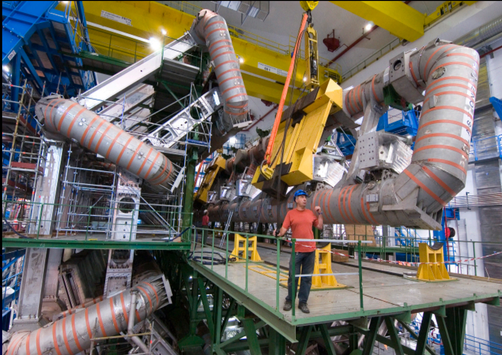
Installatie (augustus 2005) van de laatste van 8 supergeleidende 25 m lange toroides
