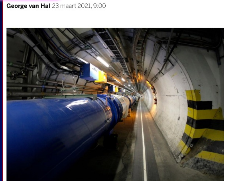
De tunnel van deeltjesversneller LHC bij Cern, Genève. In de blauwe buis zwiepen deeltjes met bijna de lichtsnelheid rond tot ze op elkaar knallen. Tussen de brokstukken van die botsing zoeken fysici naar aanwijzingen voor hoe de wereld op het kleinste niveau werkt. Beeld AP
